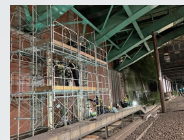
四ツ谷駅広告看板撤去工事
