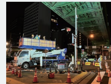
落下物防止ネット取付工事
