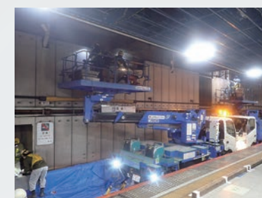
馬喰町駅老朽化パネル撤去工事
